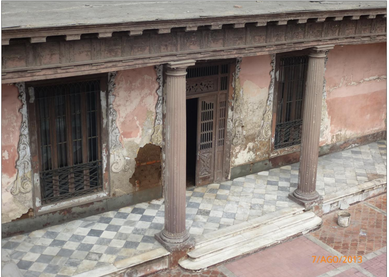
Vista Galería principal
