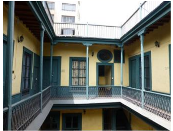
Vista pasillo 2º nivel
