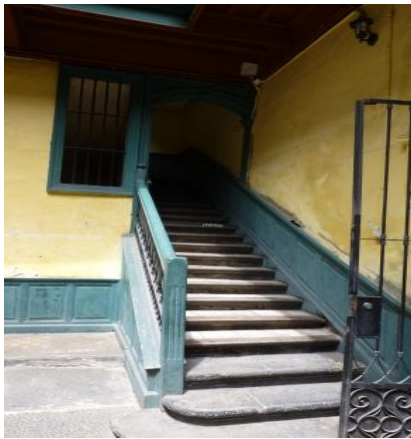
Vista de escalera principal
