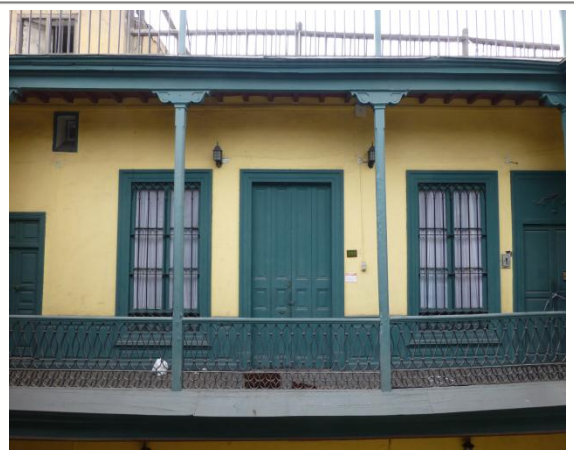
Vista pasillo 2º nivel
